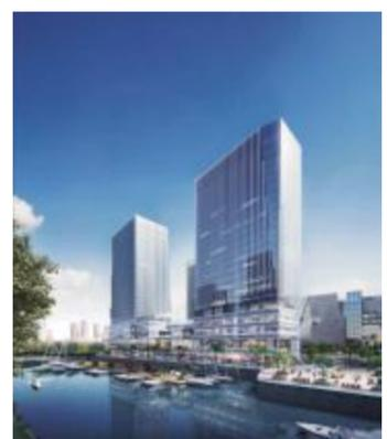
幕墙由独立的单元组合而成,每个独立单元组件内部所有板块安装、板块间接缝密封均在工厂内加工组装完成,分类编号按工程安装顺序运往工地吊装,安装可与主体结构施工同步进行,具有结构强、易安装、工期短等优点。 幕墙工程公司 叶雯俊
